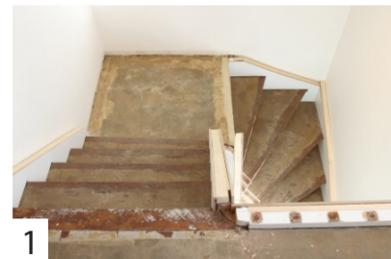
1 Alte Beläge entfernen und exaktes Vermaßen von Tritt- und Setzstufen.
