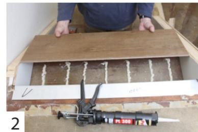
2 Fertigelemente passgenau zuschneiden – zwei Millimeter Randfuge einplanen.
