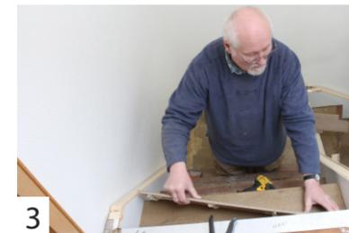
3 Erst die Tritt- und dann die Setzstufe mit Montagekleber verkleben.
