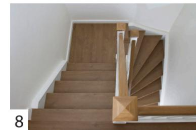
8 Zum Abschluss werden alle Wandanschlüsse mit farbgleichem Silikon abgedichtet.
