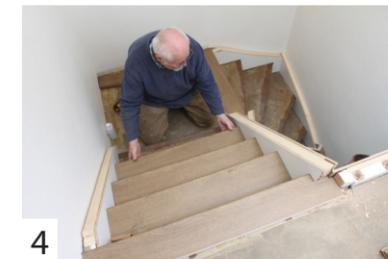
4 Von oben nach unten arbeiten. Ggf. zum Begehen jede zweite Stufe auslassen.
